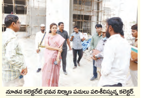
నూతన కలెక్టరేట్ భవన నిర్మాణ పనుల పరిశీలనను కలెక్టర్
