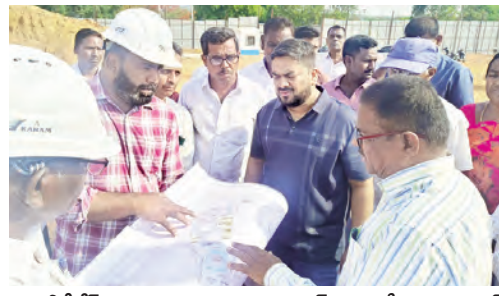
ఇంటిగ్రేటెడ్ పాఠశాల నిర్మాణ పనుల పరిశీలన కలెక్టర్
