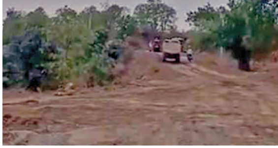
దుగ్గాతండాకు బిటి రోడ్డు నిర్మాణం దృశ్యం
