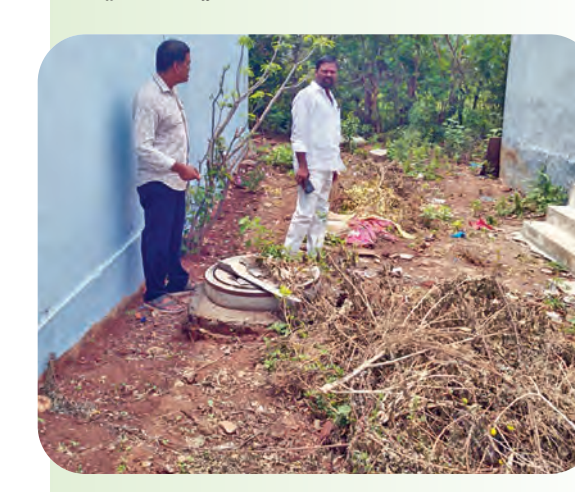
అందర్ గ్రౌండ్ డ్రెయినేజీ నిర్మాణం
