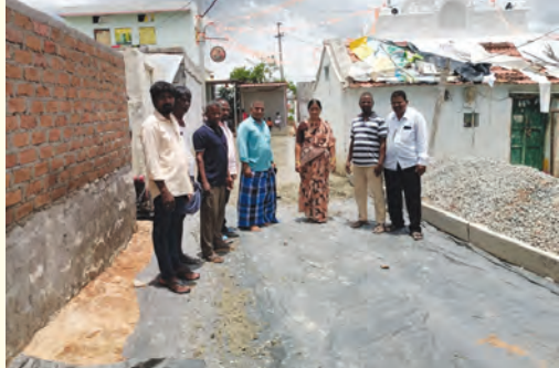
సీసీ రోడ్డు పనులను ప్రారంభిస్తున్న దృశ్యం
