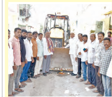
ఈస్ట్ ఆనంద్ బాగ్ డివిజన్ పరిధిలోని తాజ్ ఐస్రో సుమారు 10 లక్షలలో సీసీ రోడ్డు నిర్మాణ పనులను మాజీ కార్పొరేటర్ శ్రీ క్రేమ్ కుమార్ కార్పొరేషన్‌లకు కలిసి ప్రారంభించడం జరిగింది. ఈ కార్యక్రమంలో శతకుమార్, కృష్ణ, ఖన
